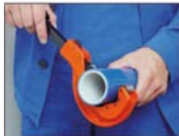
Wichtig: Rohr gerade abschneiden bzw. ablängen - kein Schrägschnitt!
