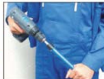
Wichtig: Systemrohr vollständig entgraten und kalibrieren - Fase mindestens 2 mm
