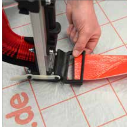
Anbausatz aufstecken und Dämm-Tak-Streifen einfädeln
