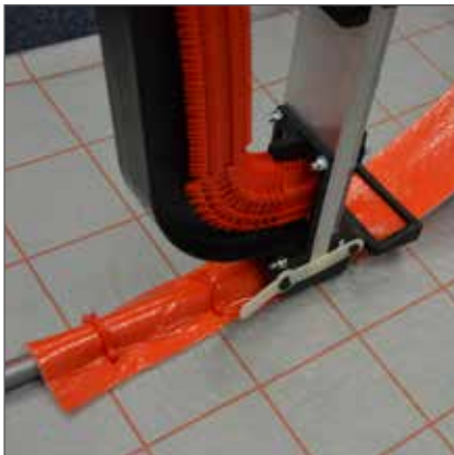
Dämm-Tak-Streifen mit Tacker-Anbausatz fixieren
