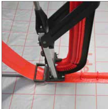
Gleichmäßig alle 10 cm befestigen
